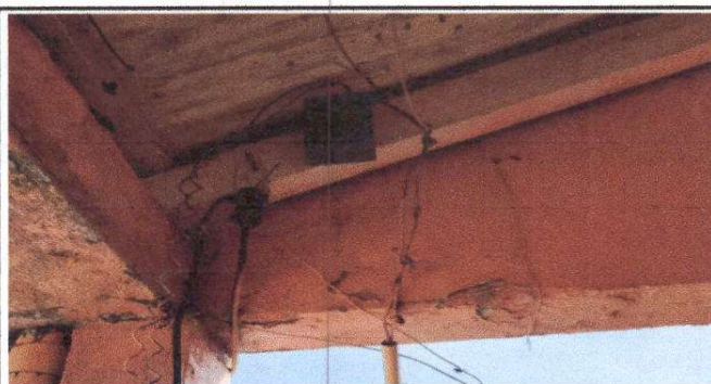
Foto 6: Sustrucción de tablero de flipones
