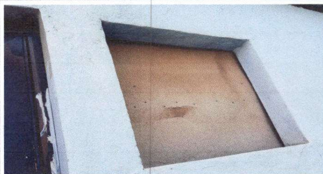
Foto 4: Sustrucción de ventanas de madera por metal + vidrio
